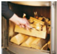
**1** Legen Sie 2 bis 3 Holzscheite auf den Rost. Stapeln Sie darüber ca. 2 Lagen Anzündholz und Anzünder. Bringen Sie die Luftzufuhr in die Position „Anzünden“ oder „max“. Entzünden Sie die Anzünder und schließen Sie die Feuerhaube. Regulieren Sie die Luftzufuhr sobald die gesamte Brennstoffmenge entzündet ist.
